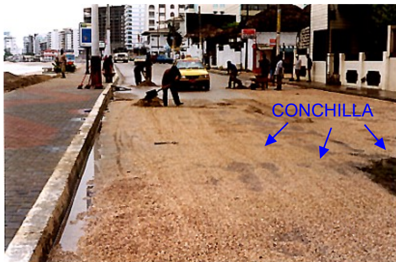
Foto 1.- Trabajadores municipales están sacando del Malecón de Salinas, la conchilla que ha sido transportada por las olas durante la marejada.
