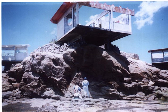
Foto 2.- Una de las viviendas destruidas por la socavación de la base del acantilado.
