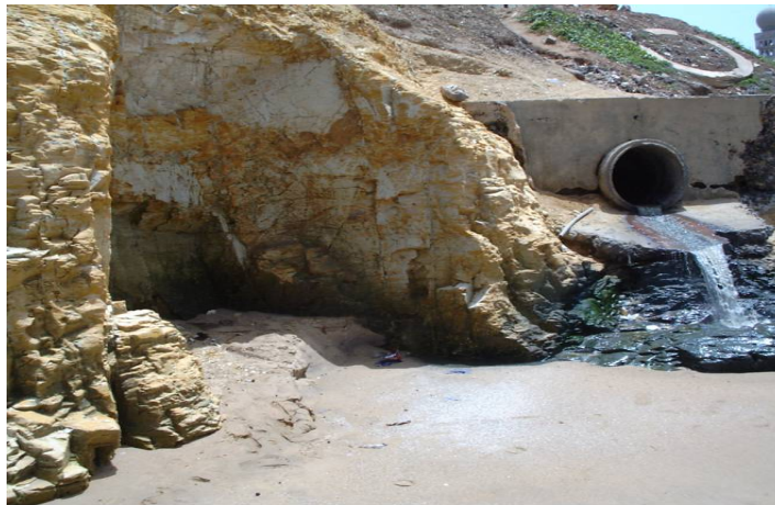
Canal d'évacuation d'eaux usées au niveau de la Porte du Millénaire
